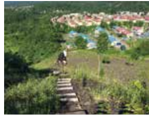
ズリ山整備作業
